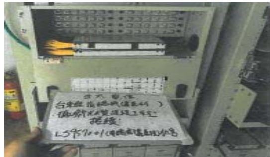
臺東縣海端鄉霧鹿村 100M 等級寬頻建置
