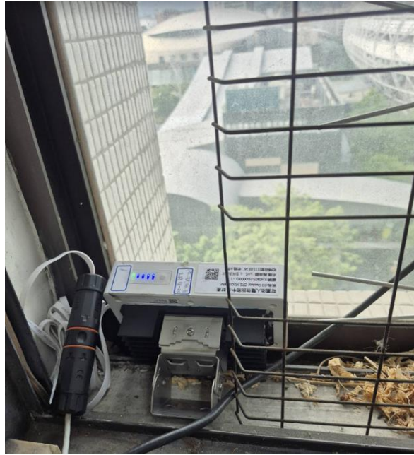
圖 5-12、台視主控室 FWA 終端架設(窗戶旁邊)
