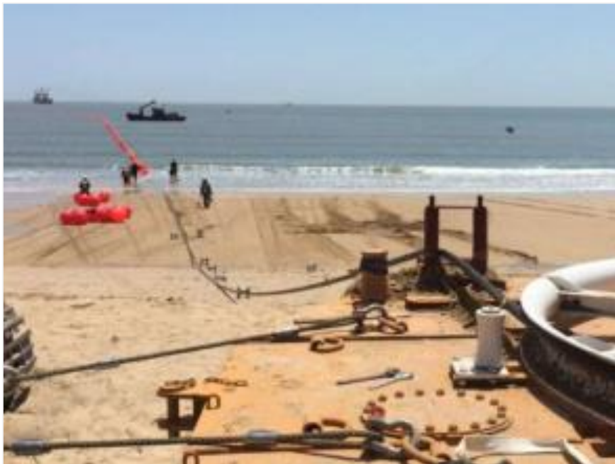
圖 14、海纜系統設置工程
