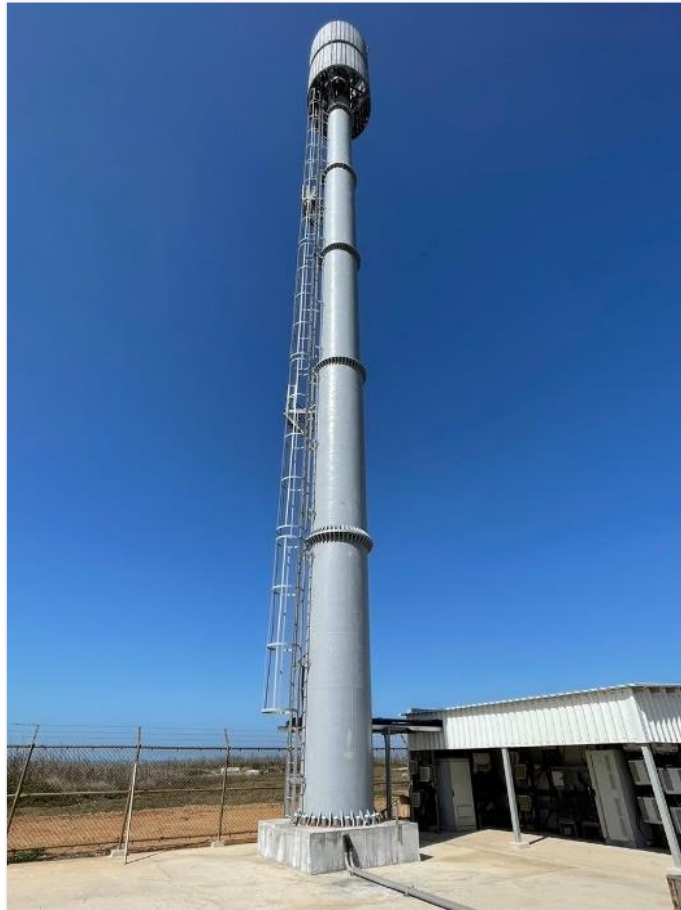
圖 24、具耐風 15 級的鐵塔
