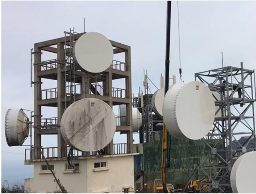
圖 29、微波系統設置工程
